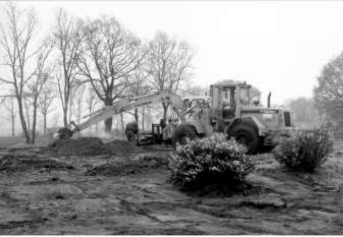
Het grote graafwerk met de kraan
