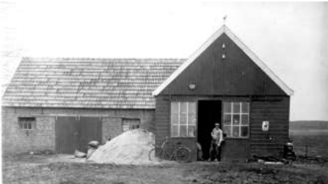
Pakhuis met stenen schuur
